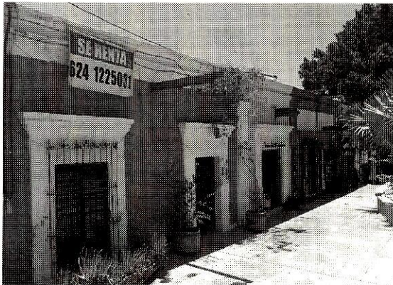
Vista actual del boulevard Mijares. Foto: Alejandro Telechea.
