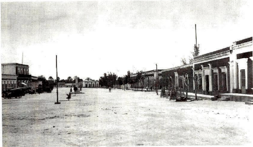
Casa Municipal sin la Torre del Reloj, reconstruida después del ciclón de 1918. ADAIH-UABCS.
